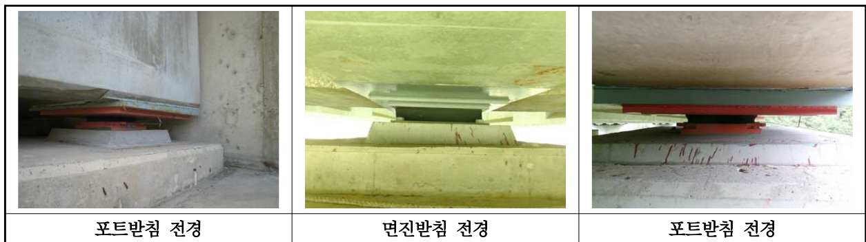
【사진 11.3.12】 교량반침 전경
