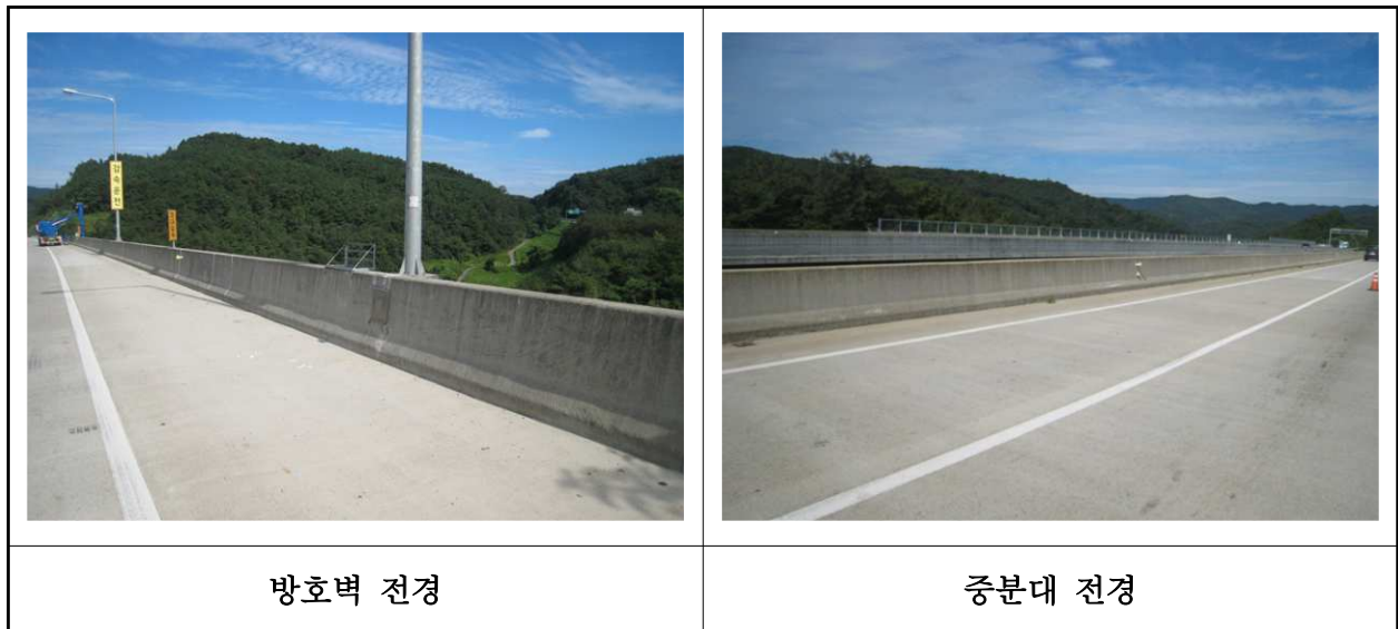
【사진 11.3.23】 방호벽 및 중앙분리대 전경
