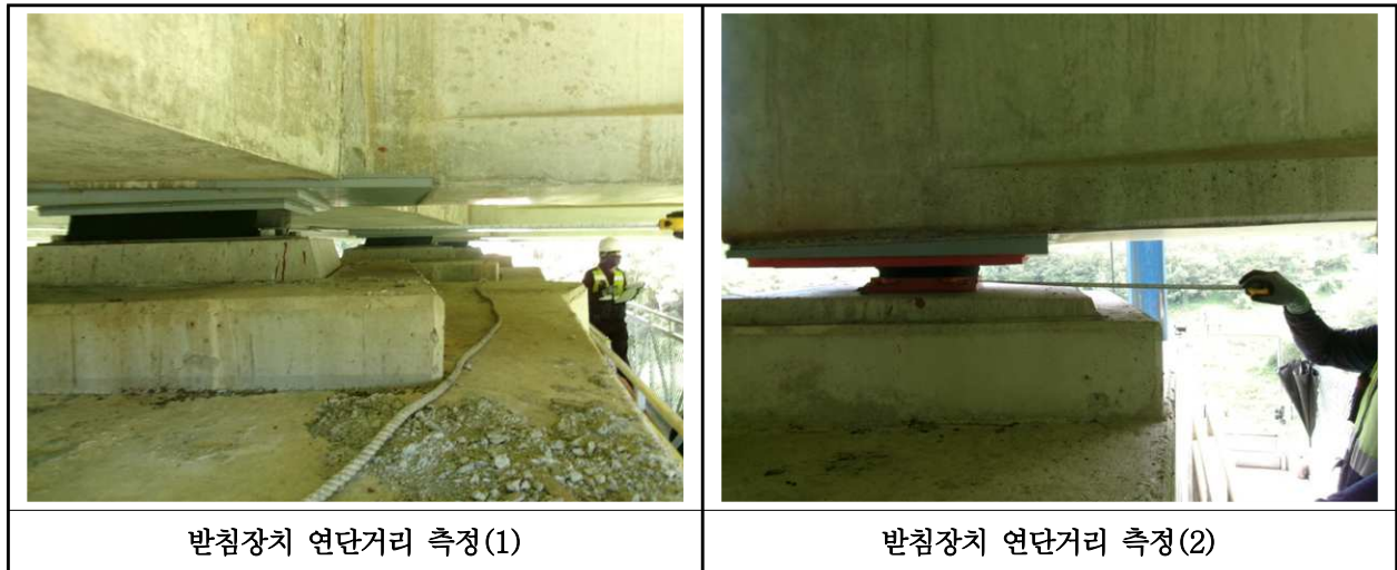
【사진 11.3.14】 교량반침장치 연단거리측정
