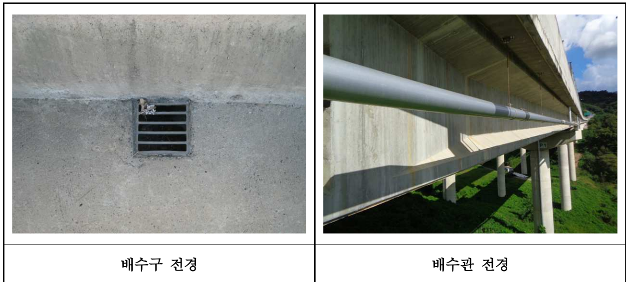
【사진 11.3.46】 배수시설 전경
