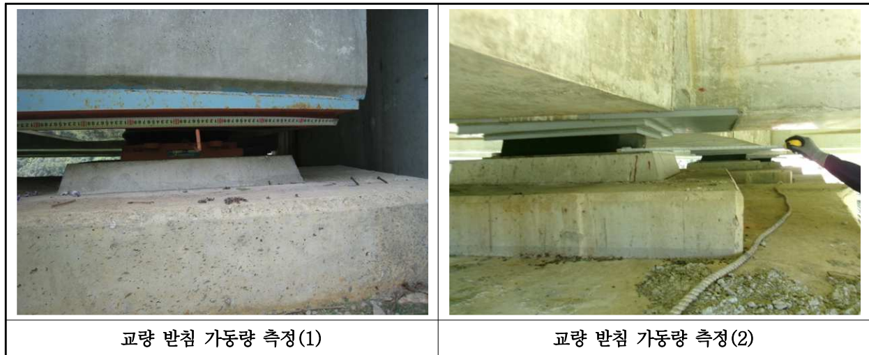
【사진 11.3.15】 교량받침 이동량 측정
