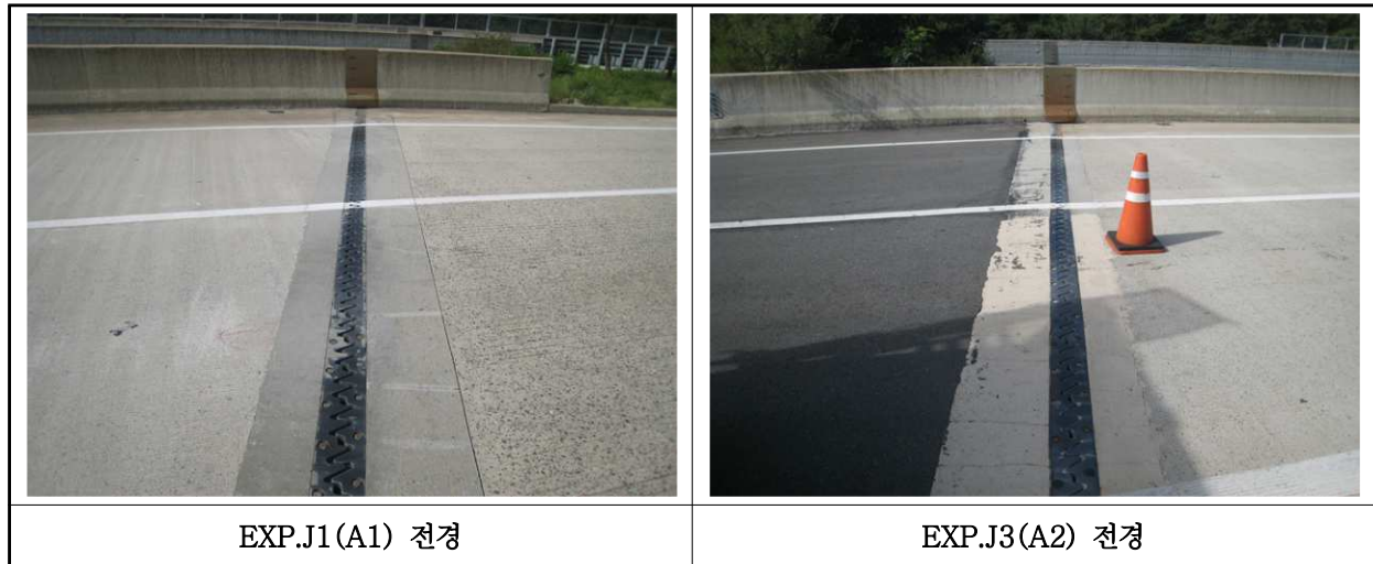
【사진 11.3.16】 신축이음장치 전경
