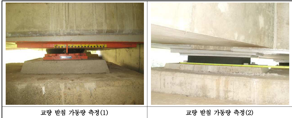
【사진 11.3.38】 교량받침 이동량 측정
