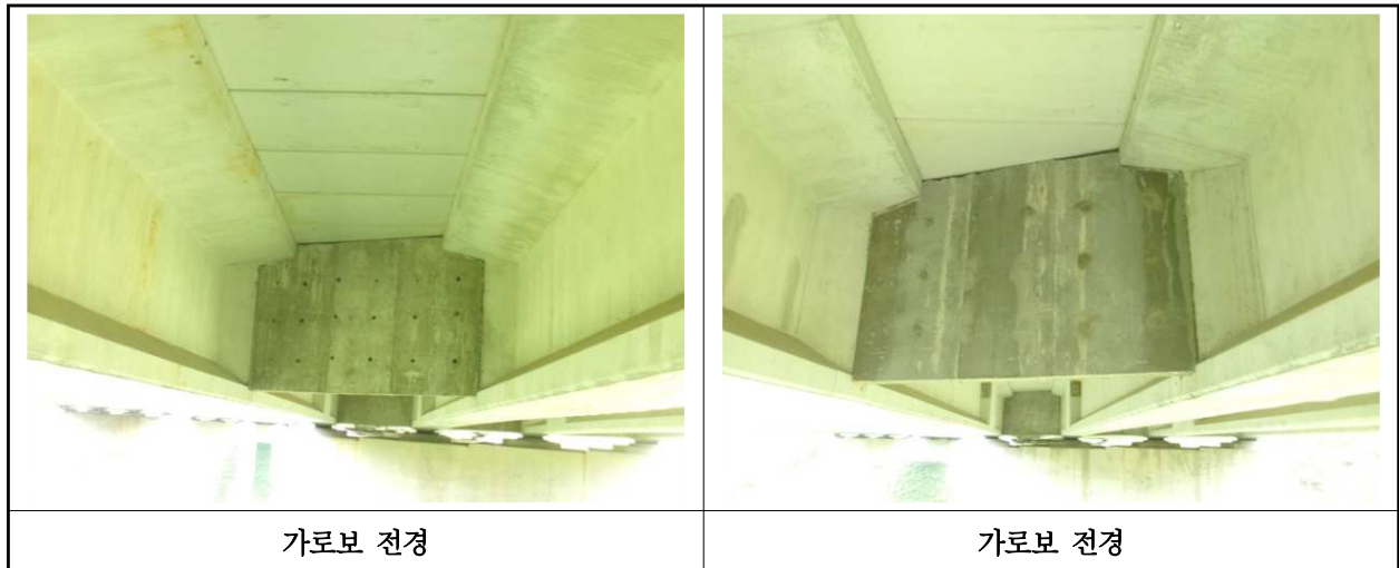
【사진 11.3.6】 가로보 전경
