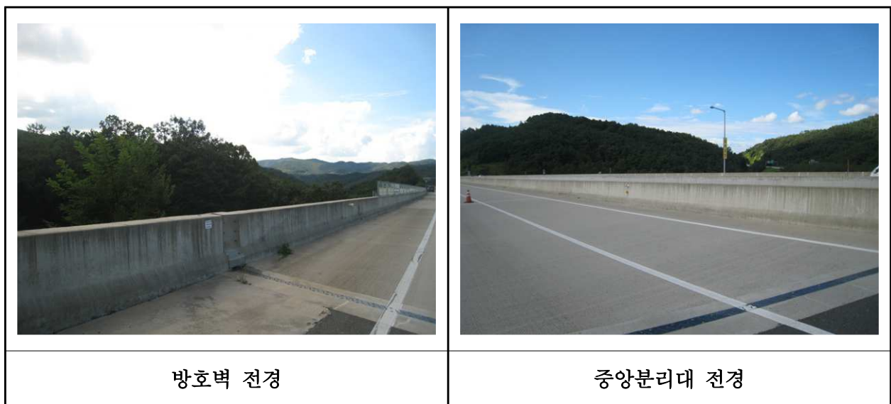
【사진 11.3.48】 방호벽 및 중앙분리대 전경
