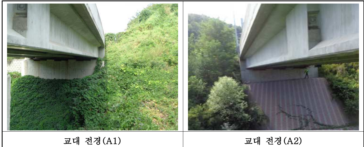
【사진 11.3.8】 교대 전경
