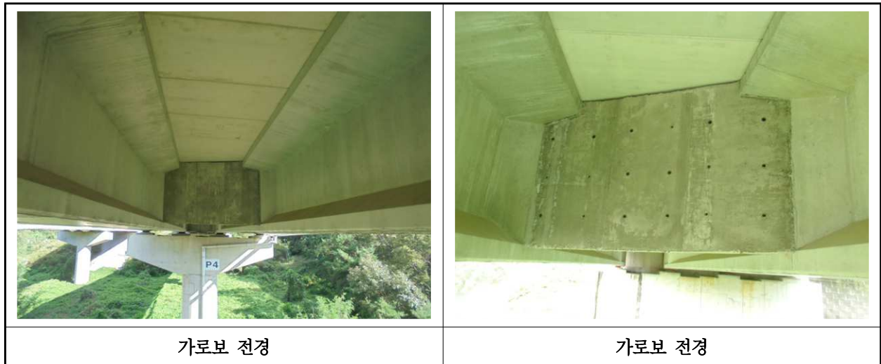
【사진 11.3.29】 가로보 전경
