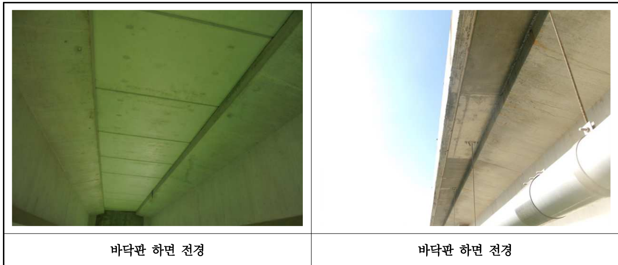
【사진 11.3.27】 바닥판하면 전경
