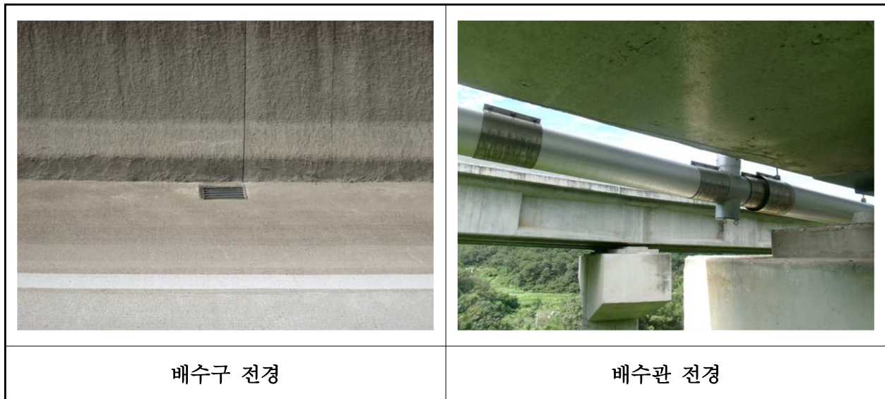
【사진 11.3.21】 배수시설 전경
