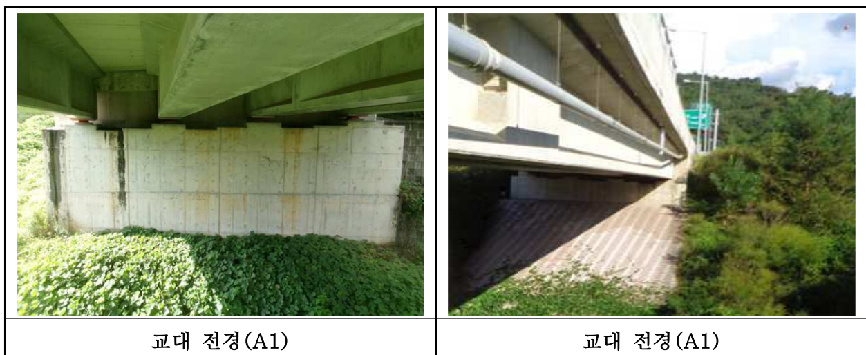
【사진 11.3.33】 교대 전경
