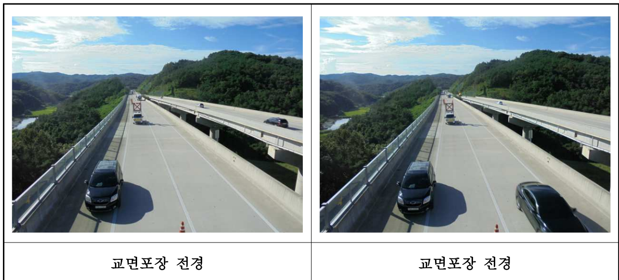
【사진 11.3.44】 교면포장 전경
