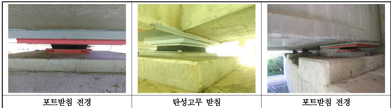
【사진 11.3.35】 교량반침 전경
